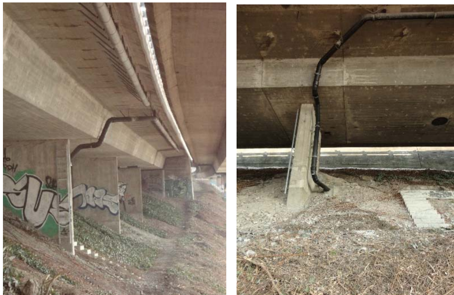
Figura 5 Tubi appesi ai viadotti
