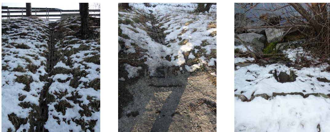
Figura 3: Canalette di scolo e scarico canalizzazioni
